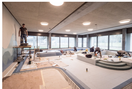
Im Rahmen des Sanierungsprojektes neu erstellt: das Planschbecken.
