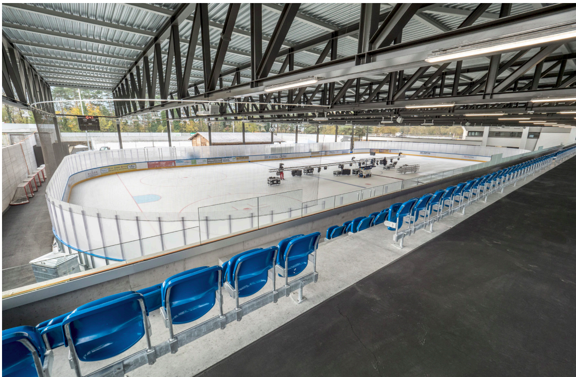
Eisfeld und Tribüne mit Stahlträgerdach.
