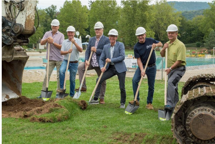
Bild: Spatenstich zur Gartenbadsanierung im Tägi Wettingen, v.l.n.r.: Peter Cathomas (Bauleiter Beck Schwimmbadbau AG), Bruno Sieber (Projektverantwortlicher Generalplaner Beck Schwimmbadbau AG), Roland Kuster (Verwaltungsratspräsident Tägi AG), Urs Kamberger (CEO Tägi AG), Kurt Müller (Leiter Betrieb & Sport Tägi AG), Bruno Meier (Leiter Technik Tägi AG)
