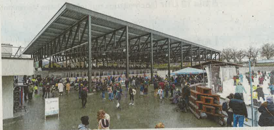
Bereits im November 2019 wurde das überdachte Eisfeld Trägerhard eröffnet.
