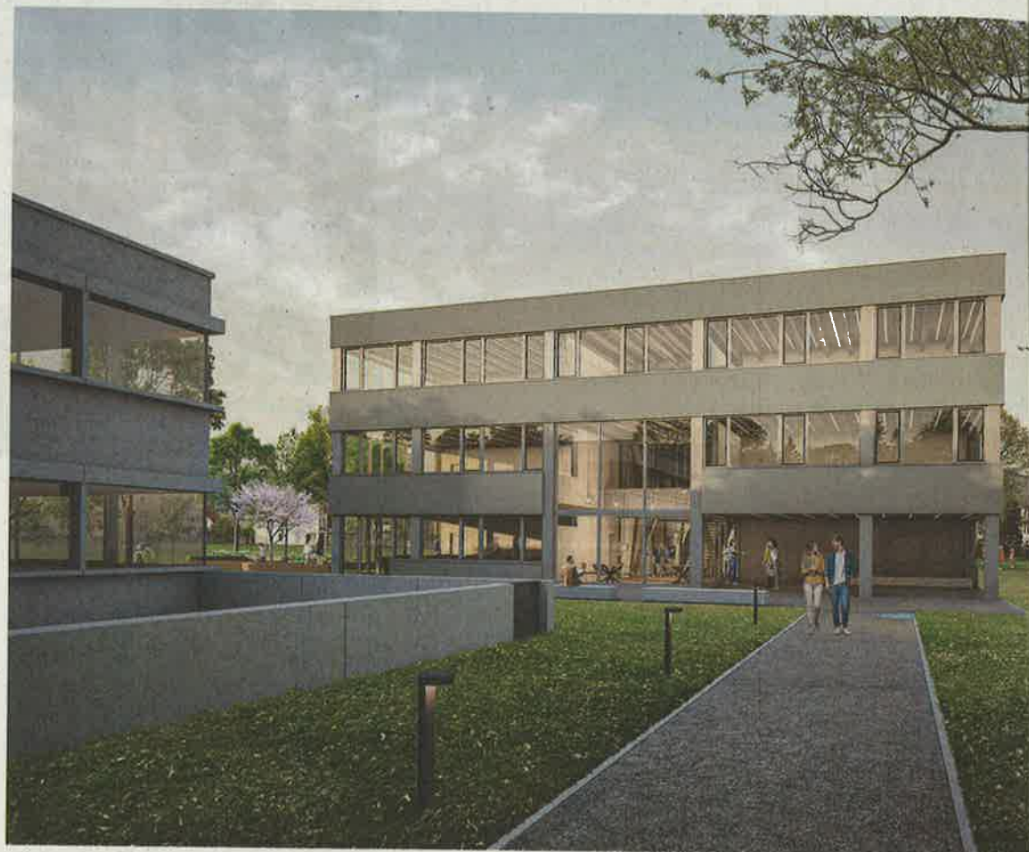
Im November 2020 entschied sich der Gemeinderat für eine modulare Hybridbauweise aus Holz und Beton
